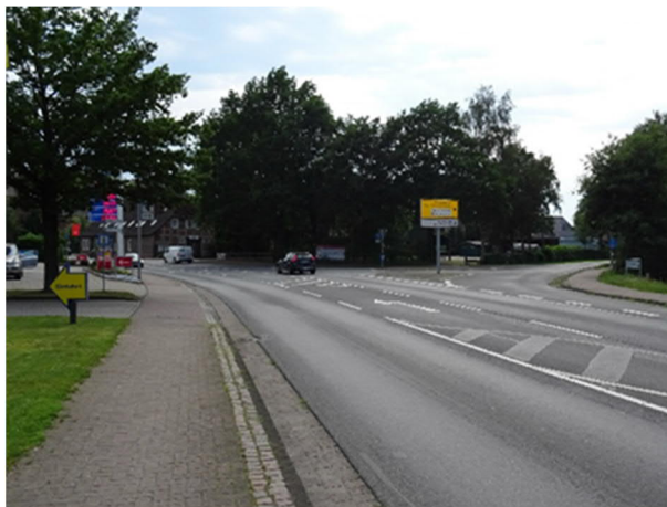
Der Knotenpunkt Im Sick ist dreistreifig gestaltet mit Bypass und mittig-liegenden Linksabbiegestreifen
